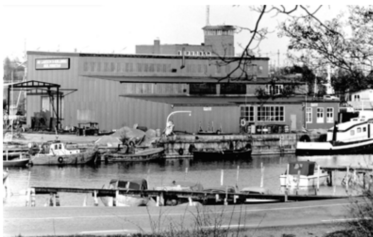
Verkstaden vid hamnen i Oxelösund, byggd 1947. Foto: Rolf Erlandsson.
