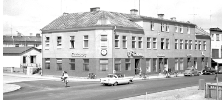
Korsningen Föreningsgatan - Höjdgatan. Konsum på Föreningsgatan 15 byggdes 1907 och kallades i folkmun för Ettan och lades ned 1963 på grund av att varuhuset Domus hade öppnats samma år. En tillbyggnad gjordes 1914 och 1944 startade en restaurangverksamhet. På övervåningen blev det barnbespising för D-skolans elever 1948. Huset började rivas den 3 augusti 1976. Fotograf: Okänd År: 1960-talet
