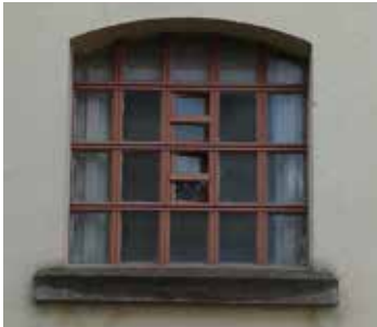
Cellfönstret som blev en flyktväg.
