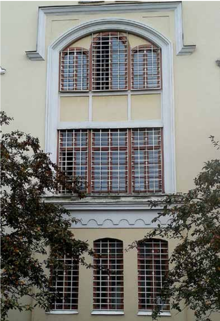
Nyköpings gamla fängelse. Exteriören är i stort sett bevarad. På bilden; norra sidan.
