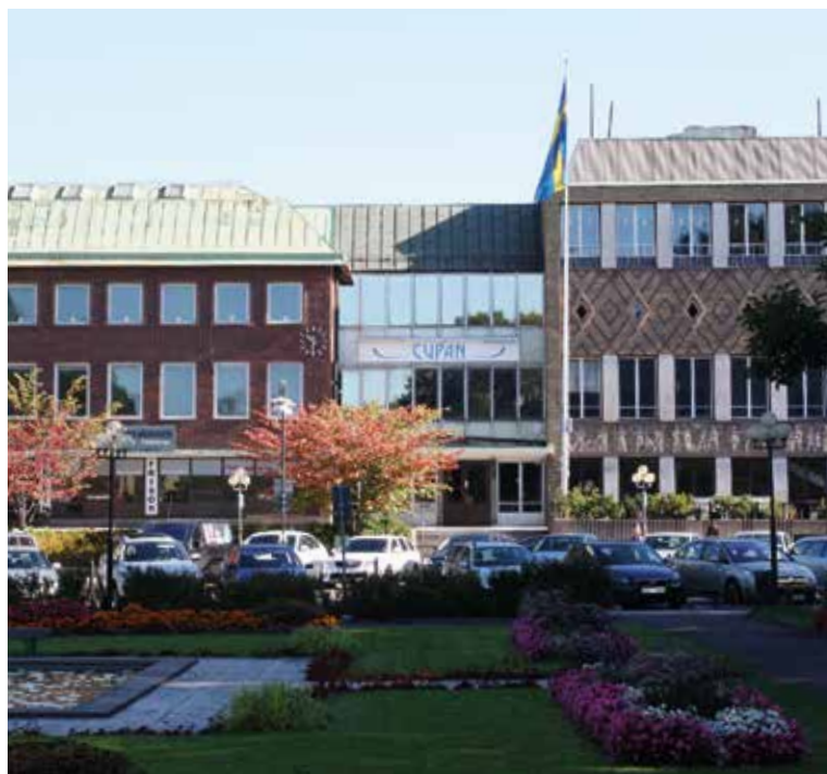
Etapp 1 i ombyggnaden av Folkets Hus innefattar den vänstra delen av byggnaden och totalt 16 lägenheter.
