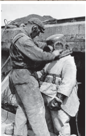
Dykararbeten i järnverkets hamn. Fotograf: Göran Ahrenberg
