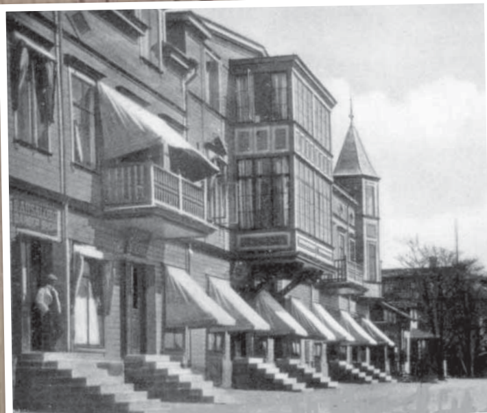
Källmanska huset på Hamngatan 9. Fotograf: okänd
