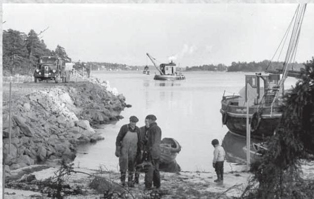
Arbetet med bygget av fiskehamn vid Öster Femöre har påbörjats. Tiden är mitten av 1950-talet. Foto okänd
