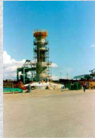
Fyren Märkeskallen byggdes i fiskehamnen 1992. Den 27 maj bogserades fyren på präm till sin slutliga destination i Ålands Hav. Fyrarna vid Märkeskallen hade tidigare vid tre tillfällen 1985, 1987 och 1991 blivit nedmejade av fartyg. Foto Jan Karlsson
