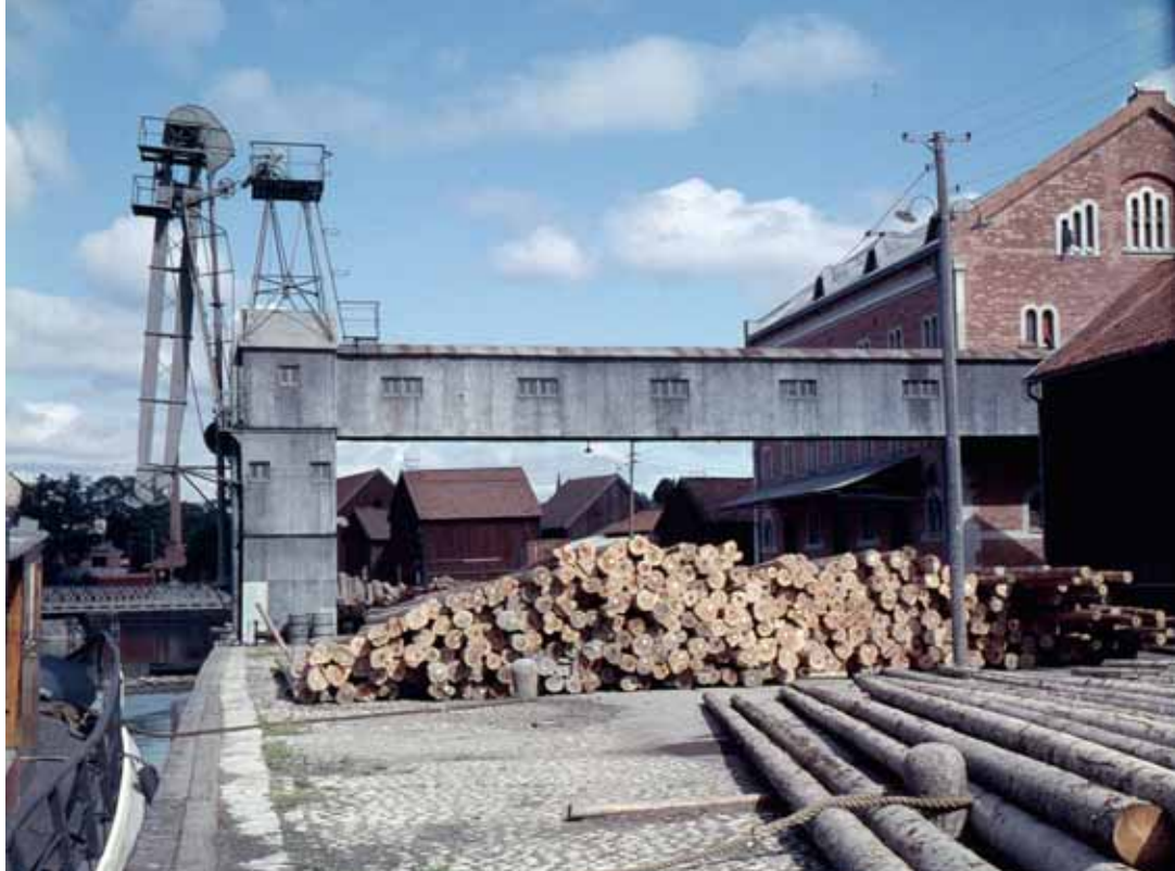
Hamnens elevator (hissanordning) med ett rullband som leder in i Storhusqvarns magasin. Detta transportsystem förde spannmål över kajen mellan fartyg och magasin. Bild från 1956. Foto Ulf Ingvar Wallnér
