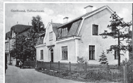
Hamngatan med Tullhuset i förgrunden. 1903-1975 låg Tullhuset på Hamngatan 23. Tullstationen flyttades 1975 till "Pärulan" på Torggatan 3. Huset revs omkring år 1975-1976. Huset till vänster kallades Källmanska nedre. Det byggdes 1896 och revs i november 1975.
