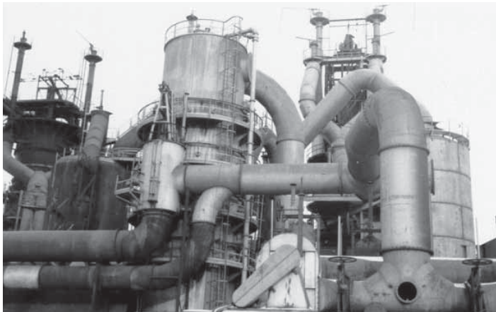
Stora bilden Bilden är tagen av Göran Ahrenberg inne i gasklockan på Oxelösunds Järnverk (numera SSAB Oxelösund). Gasklocka är en cisternliknande anläggning byggd för att lagra gas. Årtalet när bilden togs är okänt. Lilla bilden Gasreningsanläggningen vid masugnarna på Oxelösunds Järnverk. Den renade masugnsgasen är en viktig energikälla för SSAB:s egna processer, för elproduktion och fjärrvärme. Fotograf okänd. Årtal okänt. Bilderna från Oxelösundsarkivet.
