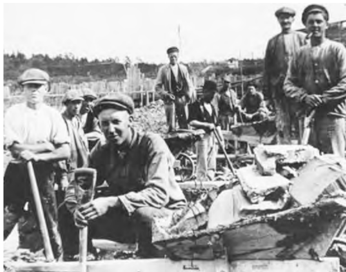
■ Kanalgrävningen 1921 utfördes med spadar och skottkärror. Arbetet leddes av ingenjör Gösta Pousette och sysselsatte ett 40-tal arbetslösa män. Från vänster Torsten Källman, Allan Olsson, Nils Lindqvist, Alvar Andersson, Gunnar Ljunggren (vegamösa), fyra okända personer samt Ture Odsvall (med pipa). Foto Oxelösundsarkivet
