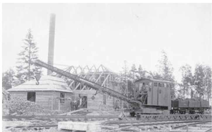
Provisorisk kraftstation. Järnverket var självförsörjande med elektrisk kraft under byggnadstiden. Lokkranen är densamma som under benämningen Smilo gjorde god tjänst vid järnverket ända in på 1950-talet. Bild från 1914. Foto Gösta Pousette
