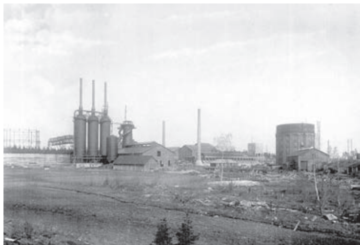
Masugnsanläggningen. Till vänster gasklockan och brokranen. Till höger pumpstationen och den mekaniska verkstaden som även idag står kvar. Mellan masugnen och pumpstationen ligger koksverket. Bild från 1916. Foto Oxelösundsarkivet
