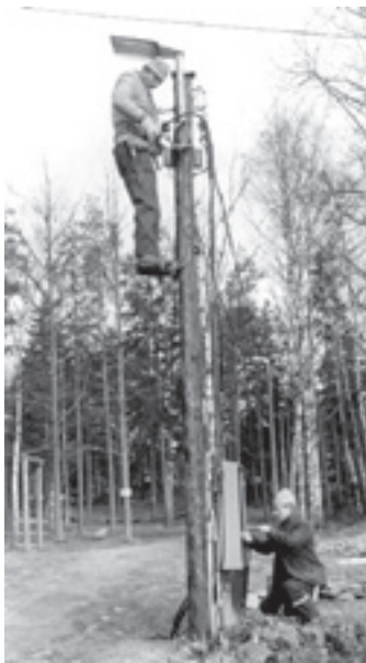
Här pågår arbetet med belysning i motionsspåret ute på Jagersö. Elverkets personal skall dra ljus i en slinga på 2,5 km.
