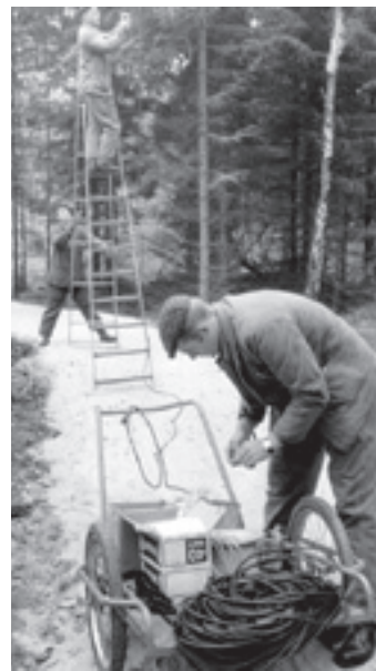
Här pågår arbetet med belysning i motionsspåret ute på Jagersö. Elverkets personal skall dra ljus i en slinga på 2,5 km.
