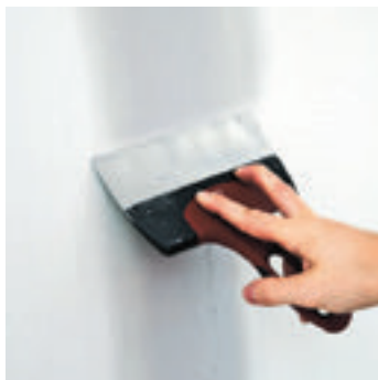
Steg 1: Underarbetet är A och O! Se till att spackla alla ojämnheter ordentligt
