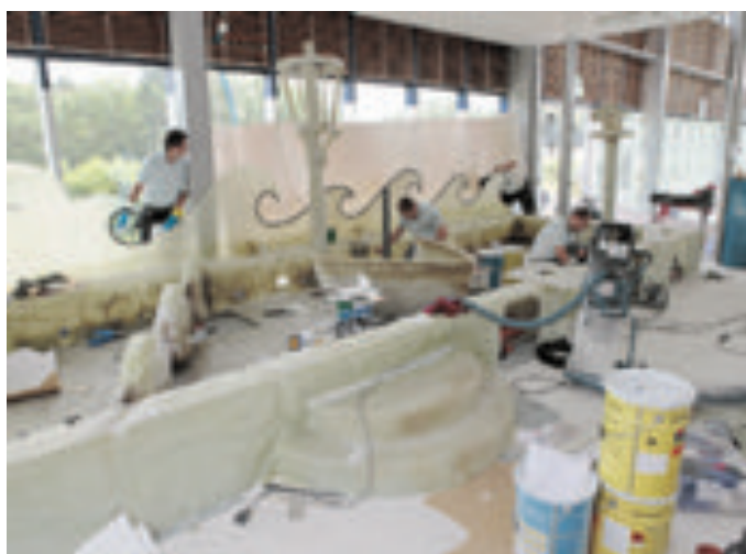
I anslutning till den lilla bassängen byggs ett ”barnbadlandskap”.
