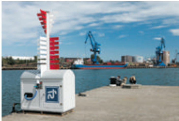
En åtta meter lång slang kopplas till båtens toalettank. Med ett enkelt knapptryck påbörjas sedan tömningen. Efter tömning rullas slangen automatiskt in igen.
