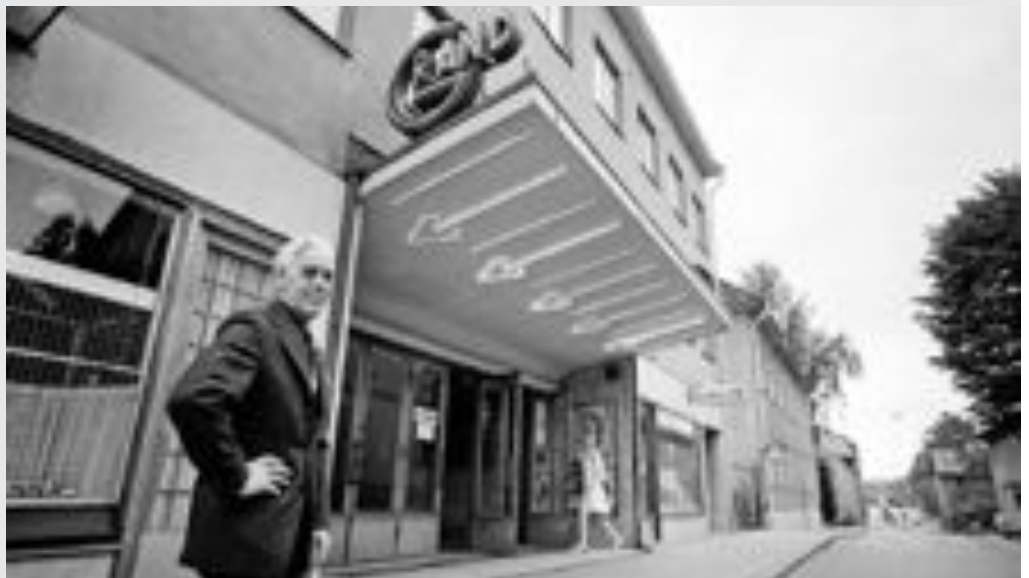
→ Grand går i graven. Ett faktum som bevitnas av föreståndaren Sivert Jonsson. Datumet är den 3 juni 1973. Fastigheten i tre våningar på Brunnsgatan 35 uppfördes 1937 då även Grandbiografen bjöd in till premiärföreställning. Efter nedläggningen byggdes lokalen om till diskotek Bankiren 1976 och inhyste senare även en loppmarknad i flera år. Foto Alf Ralmé
