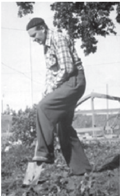
Den 23/9 var byggandet igång här gräver kommunalborgmästare Leo Holmgren täckdiken.
