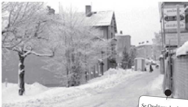
Här pågår bygget av Epa-huset till höger. På vänster sida ligger charkuteriaffären RT's Livs, apotekshuset, C-skolan och i mitten ser man D-skolan. Vägen är Föreningsgatan i den gamla sträckningen.
