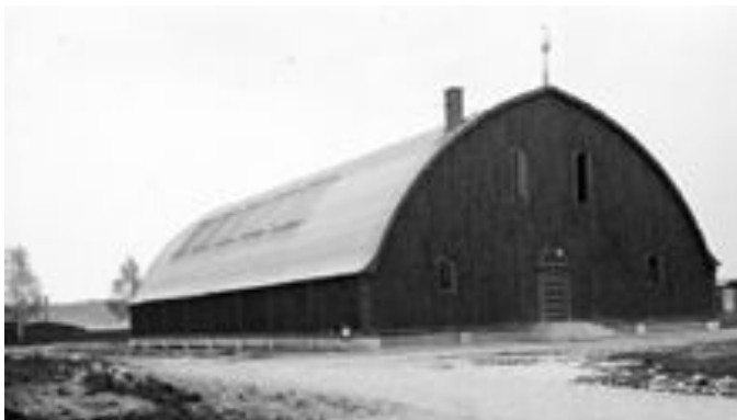
Tennishallen i Nyköping. Tennishallen är i ombyggt skick nu en del av äldreboendet invid Kungsgatan – Fruvängsgatan. Foto: Dan Samuelsson.
